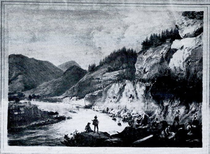
Die Sprengarbeiten in der Badelwand im Juni 1844.
