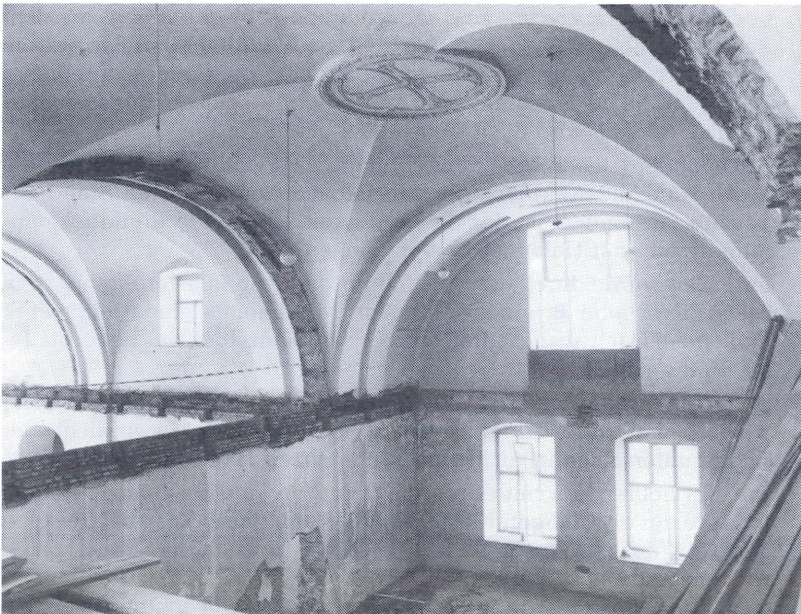
Blick in den ehemaligen Kirchenraum
